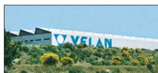
Lisbon, Portugal Velan Válvulas Industriais, Lda.
