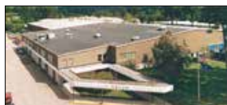
Williston, États-Unis Velan Valve Corp., Usine 3
